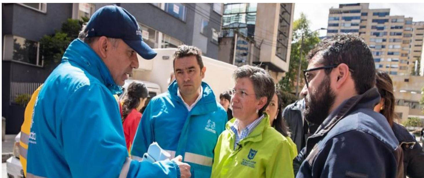
Funcionarios del Acueducto; la alcaldesa, Claudia López; y el jefe de gabinete, Anderson Sanabria, en recorrido por las obras de las calles 92 y 94.
