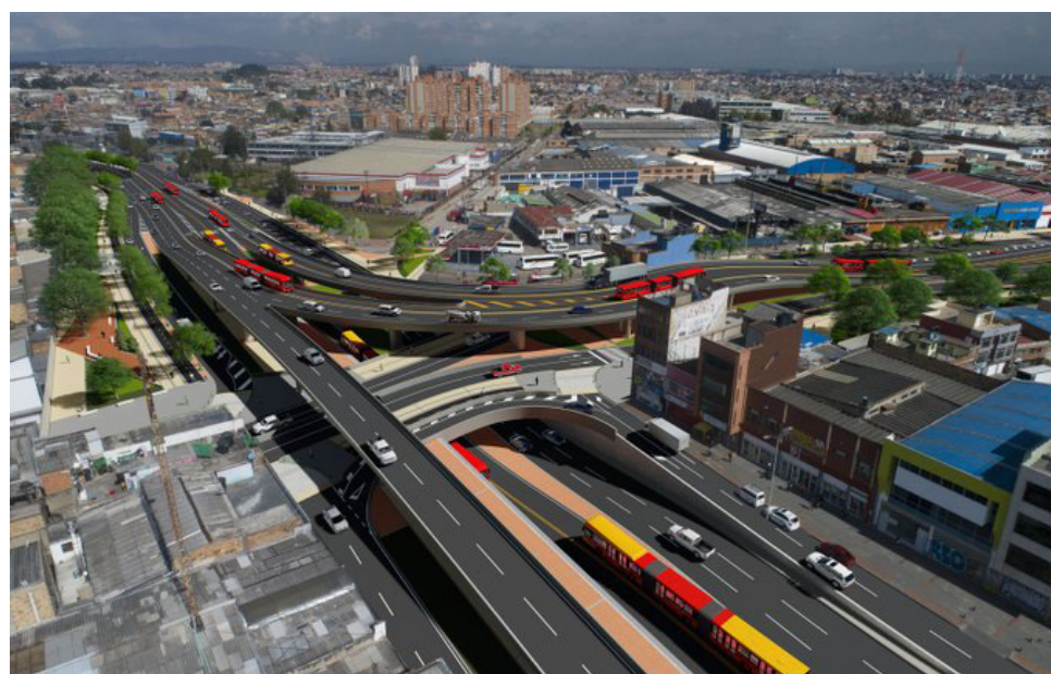
Con el nuevo puente Venecia se entregan carriles exclusivos para el Sistema de TransMilenio y otros para el tráfico mixto.
