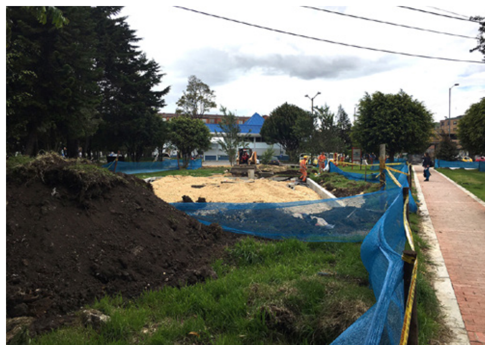
Parque en remodelación Cra.73 Cl.48
