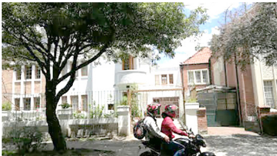
Calle 34 # 20-23 Irregularidades en la construcción de edificio. Constructora Mileto Constructores S.A.S.
