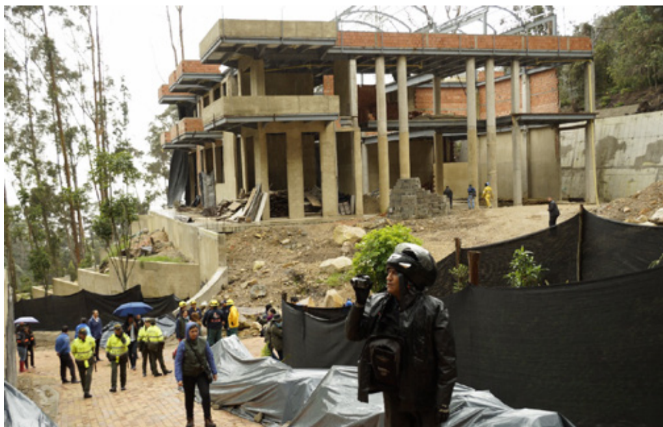
Mega construcción en Bagazal
