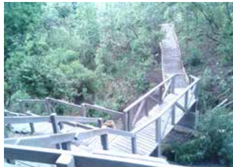
Puente quebrada Moracé, localidad de Chapinero
